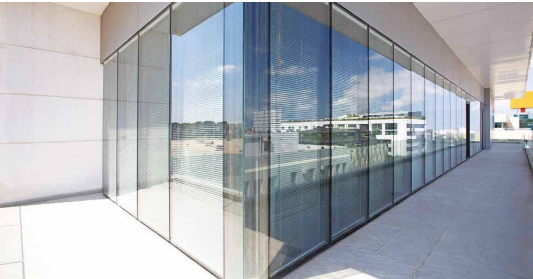
La largeur réduite des profils est de 52 mm.
