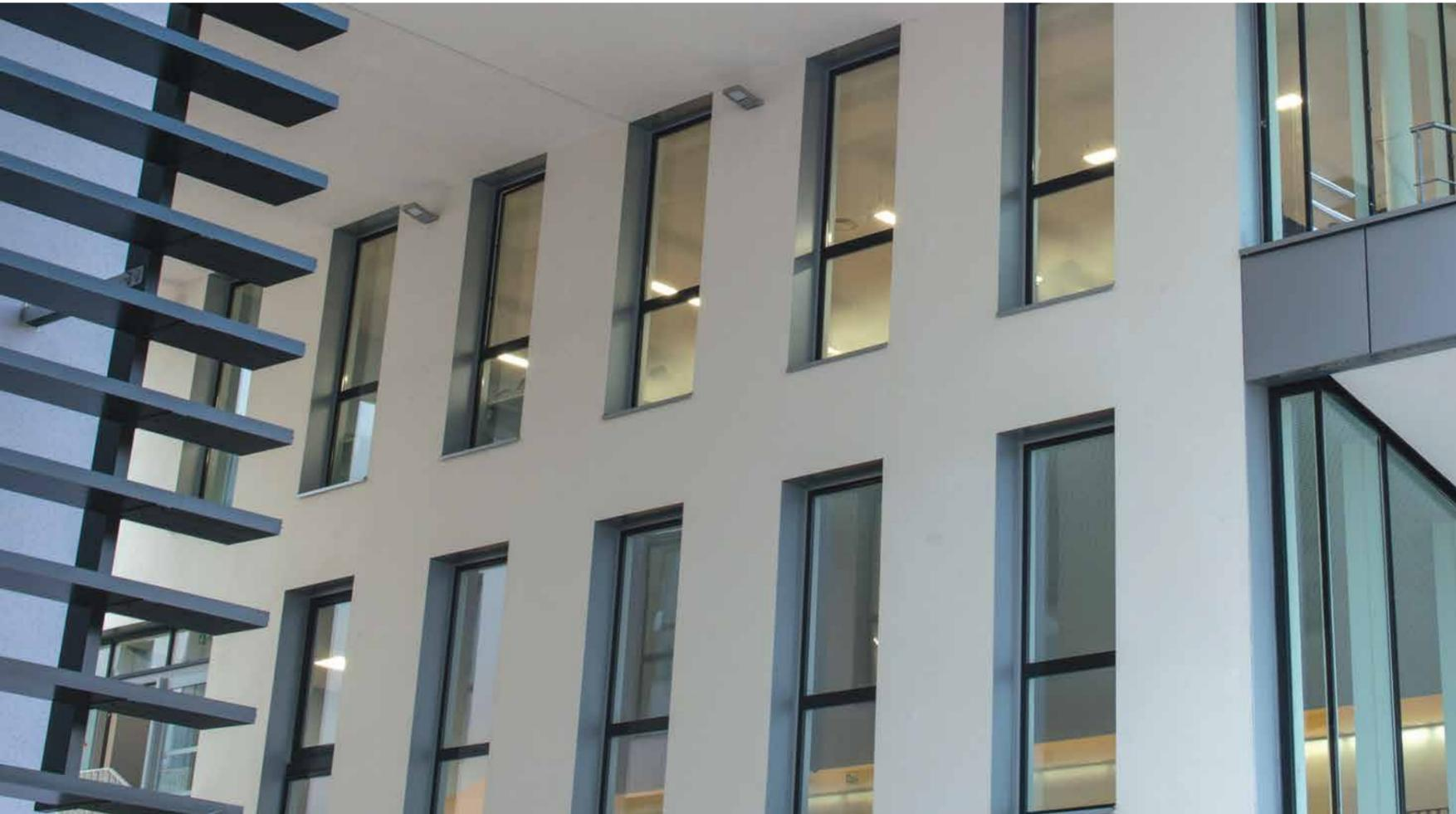
Fenêtres et portes-fenêtres à frappe à rupture de pont thermique, ouvrants à la française, oscillo-battants, fixes, soufflets, portes à 1 ou 2 vantaux.
