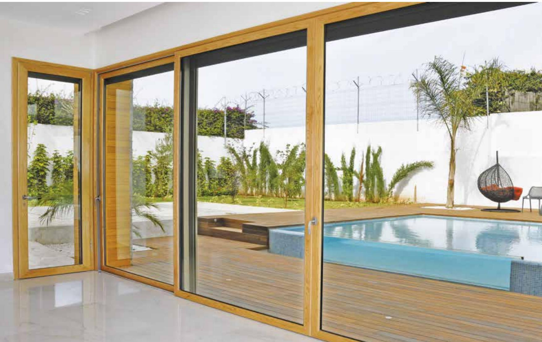
Fenêtres et portes-fenêtres coulissantes 2, 3 et 4 vantaux sur 2 rails.
